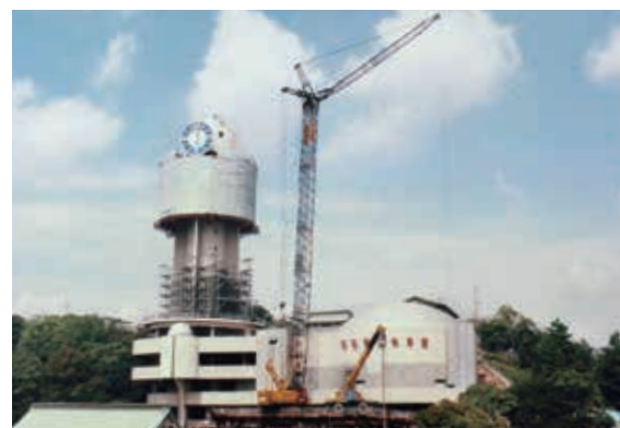
▲震災復旧工事のようす
