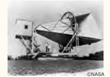
宇宙マイクロ波背景放射が最初に観測されたホルムデルのベル研究所にある15メートルホーンアンテナ ©NASA
